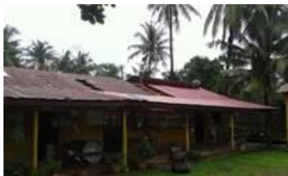
Das Dach der Bildungshütte wird geflickt und teilweise erneuert
