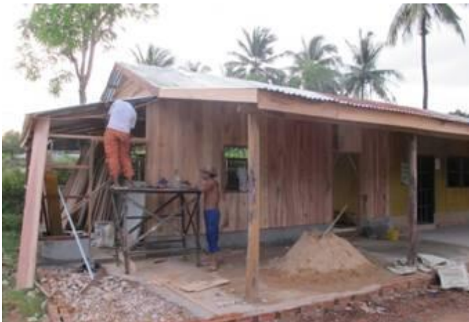
Arbeiter bei der Erweiterung der Bildungshütte
