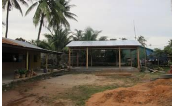
Überdachte Fläche auf dem Hüttengelände
